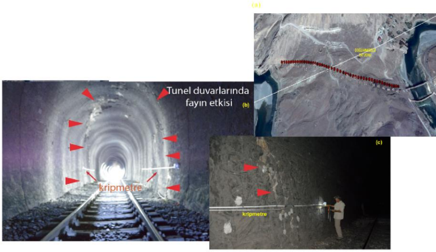
Şekil 3. (a) Google Earth görüntüsü üzerinde tünel güzergahı. Numaralı kırmızı noktalar, tünel içinde yapılan konum okumalarını göstermektedir. 1947 yılında yapılan ve derinliği 50m olan tünelin genişliği 4.90m, yüksekliği 5.87m ve uzunluğu 787m'dir. Beyaz çizgi, DAF'ın konumunu belirtmektedir. (b) Fayın tüneli kestiği yerin tünel içinden alınan fotoğrafı. (c) Fay tarafından kesilen duvara yerleştirilen kriptometre istasyonunun detay görüntüsü. Ayrıca, (b) ve (c) üzerinde kriptometre konumları da görülmektedir. Kırmızı oklar, fay tarafından etkilenen konumları işaretlemek için kullanılmıştır.
